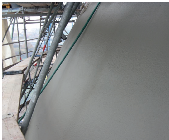
Na rozdíl od běžných směsí polymeru a cementu je povrch produktu Zentrifix F 92 odolný vůči ultrafialovému záření a povětrnostním vlivům.
